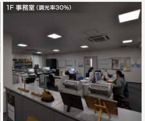
1F 事務室 (調光率30%) 終業後は調光率を徐々に下げ、帰宅しやすい雰囲気へ
